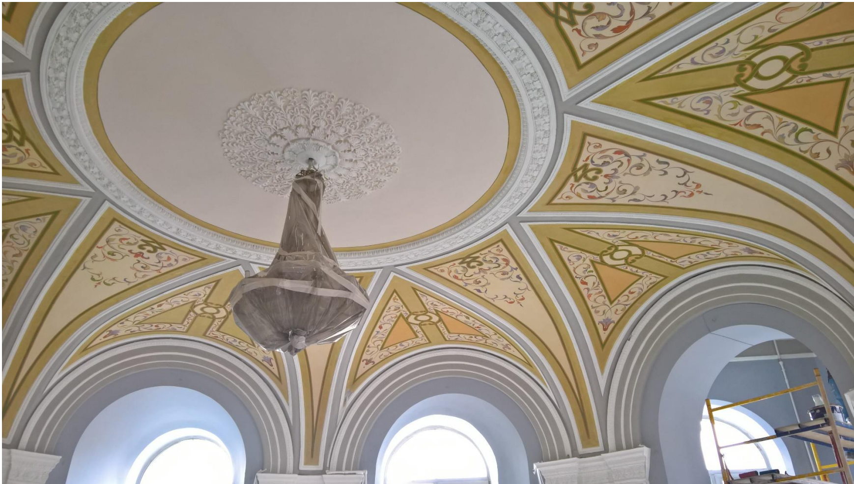
Ремонтные работы в пом. 53-01 (Б. Морская, 67)
