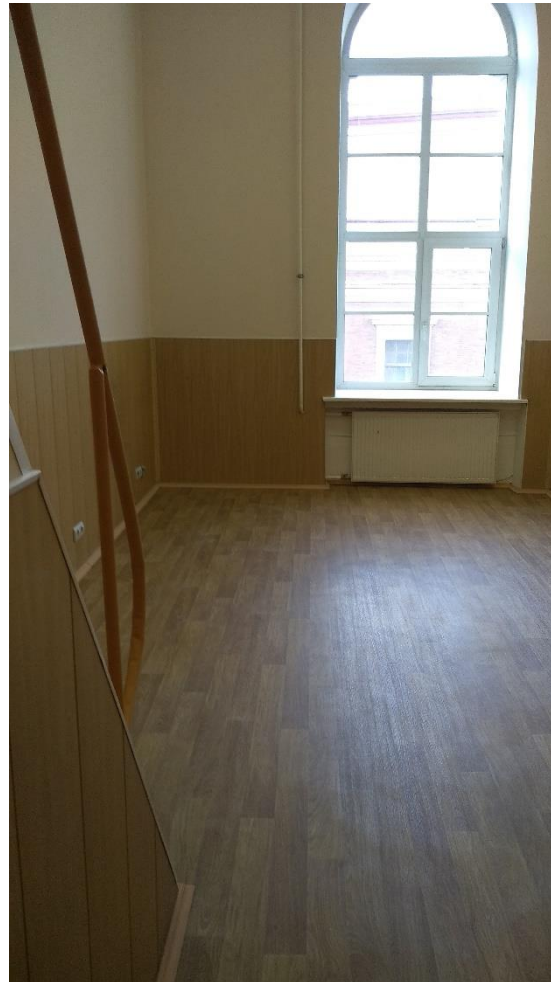
Ремонт аудиторий (Б. Морская, 67)
