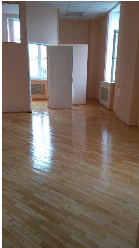
Ремонт аудиторий (Гастелло, 15)
