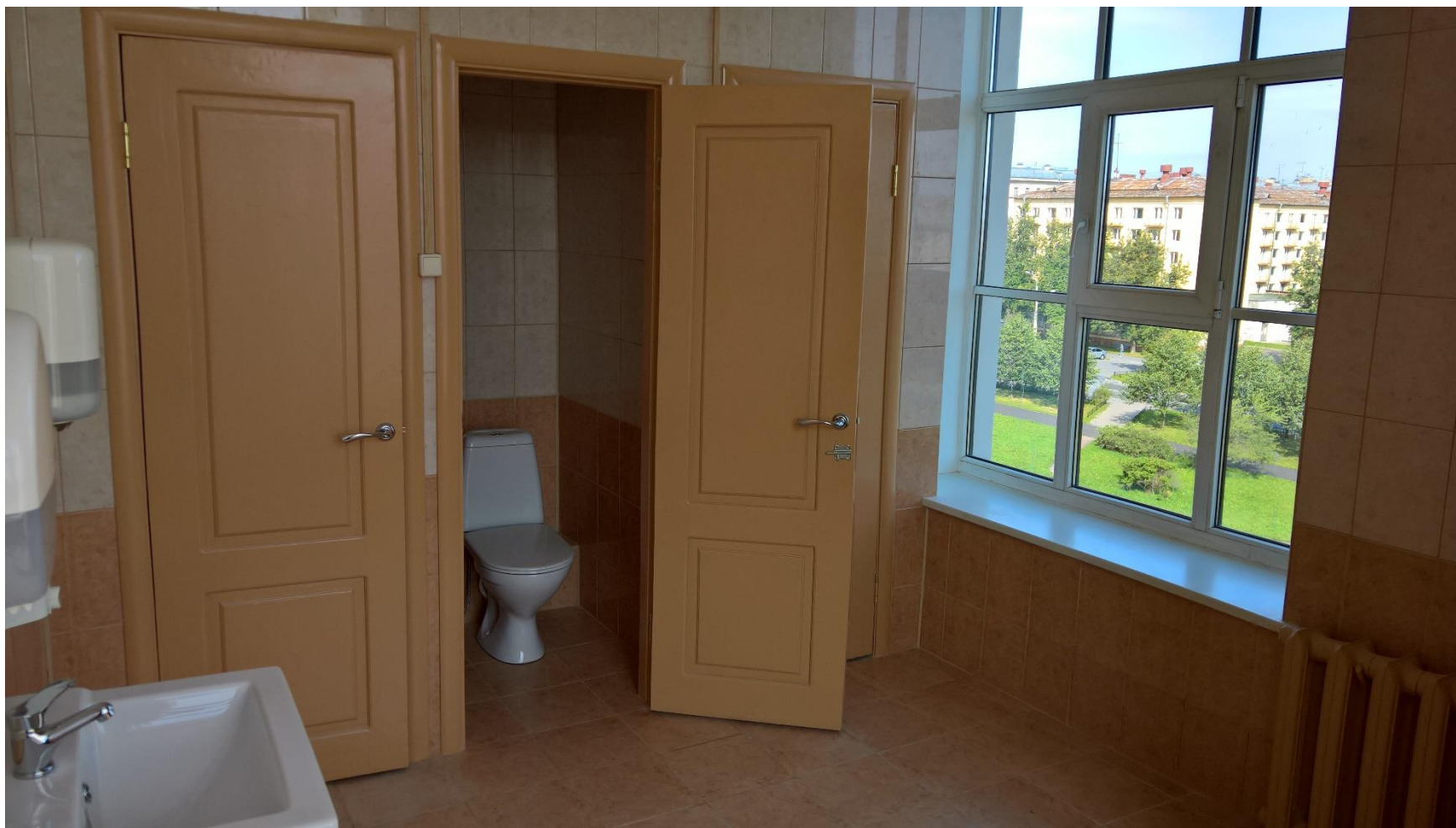
Ремонт санитарных комнат (Гастелло, 15)
