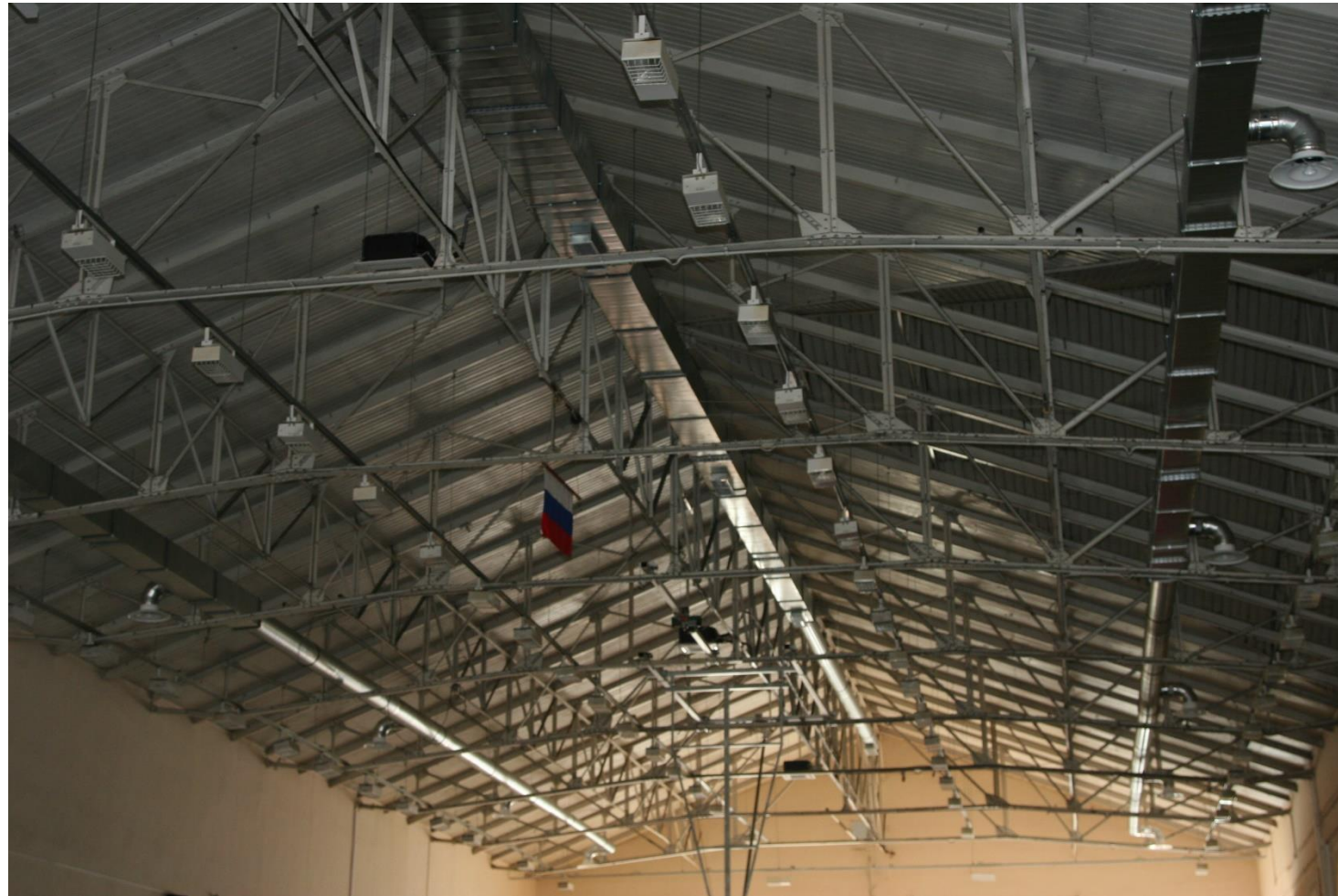
Монтаж системы приточно-вытяжной вентиляции в спортивном зале (Б. Морская, 67)
