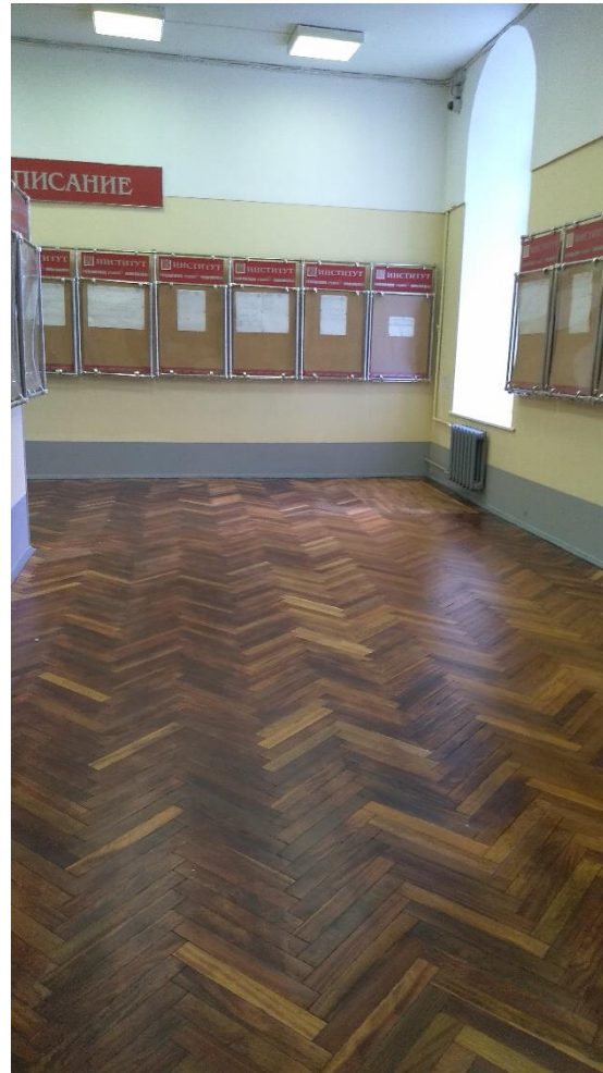
Ремонт коридоров (Б. Морская, 67)
