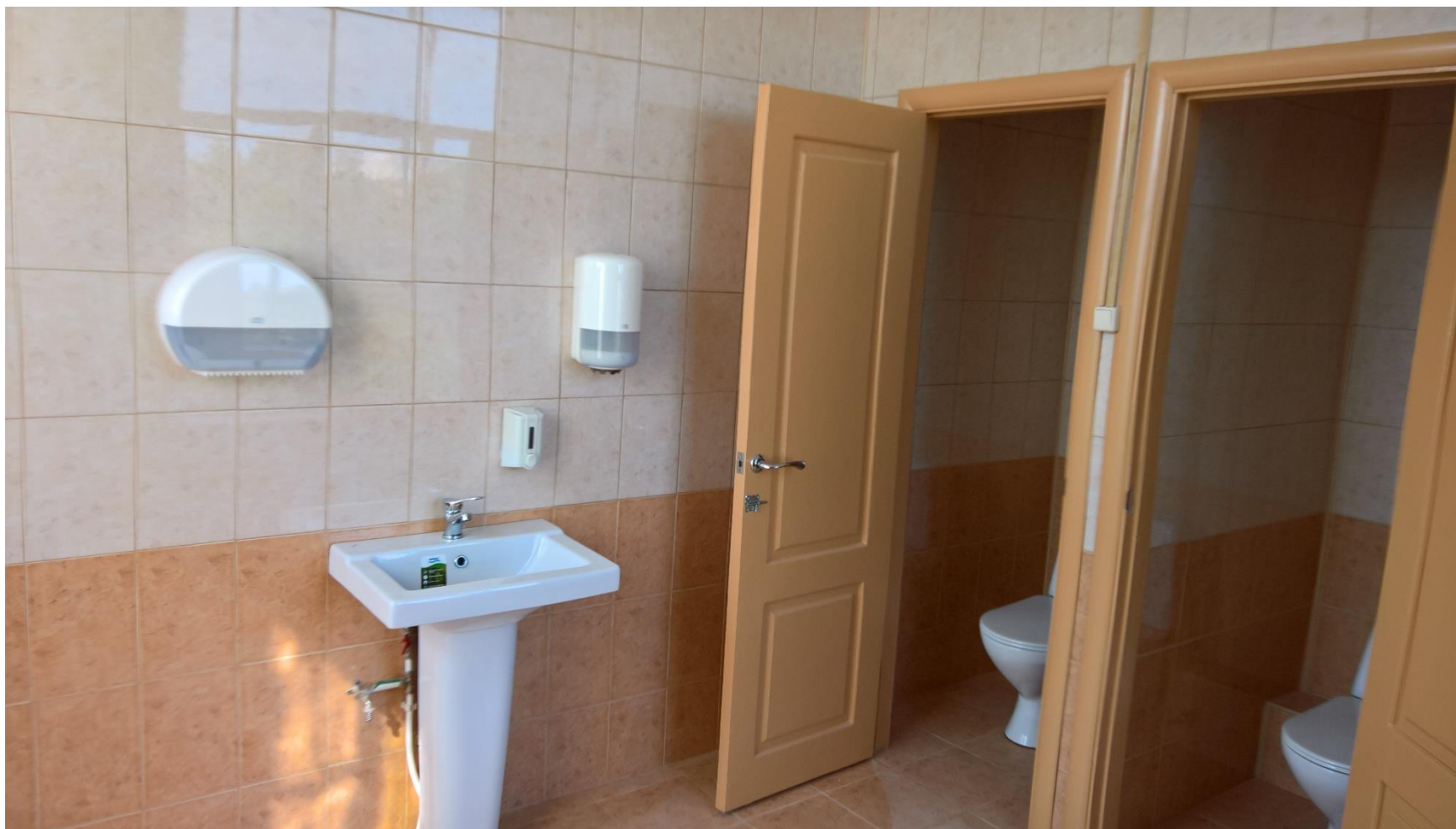
Ремонт санитарных комнат (Гастелло, 15)
