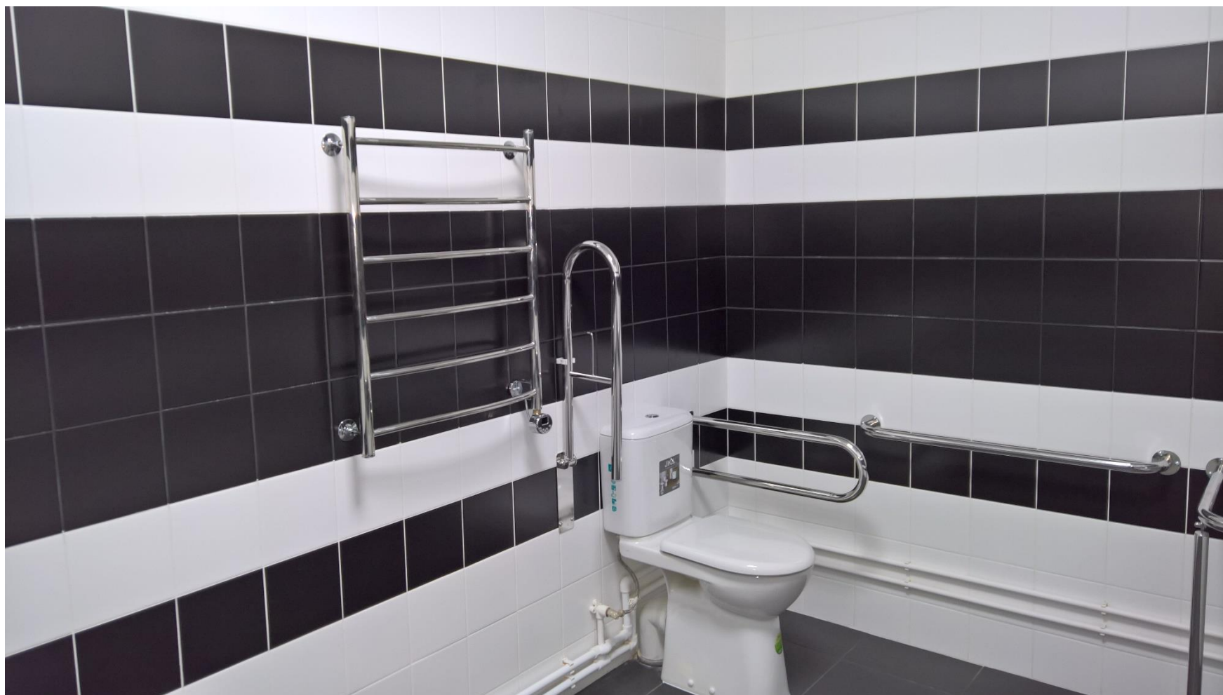
Ремонт санитарных комнат по программе «Доступная среда» (Ленсовета, 14)
