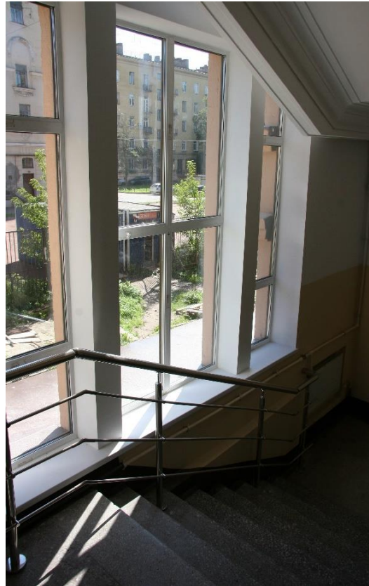
Московский 149В. Замена оконных блоков центральной лестницы
