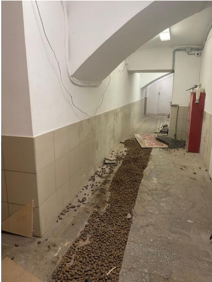
Аварийный ремонт ХВС и отопления 51-08В
