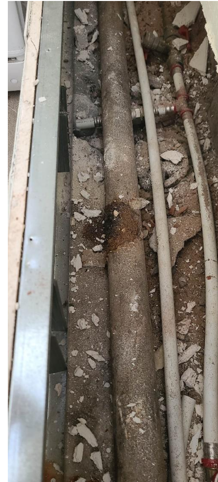
Аварийный ремонт ХВС и отопления ОКБ РЭС
