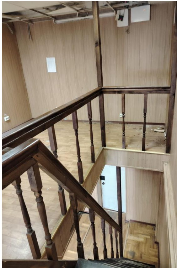
Ремонт помещения 52-27 (PCO)
