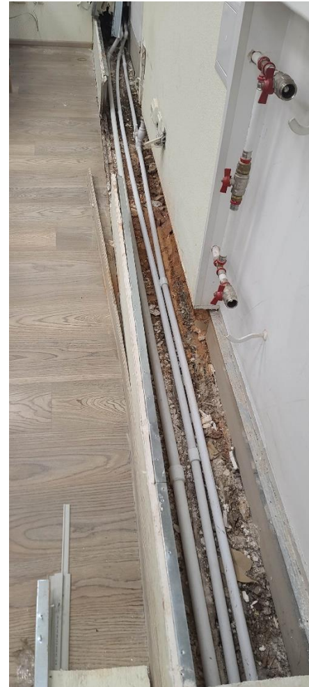
Аварийный ремонт ХВС и отопления ОКБ РЭС
