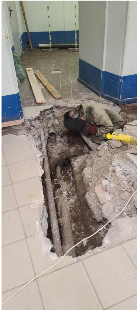
Аварийный ремонт трубопровода отопления лестница у РИЦ и Касс
