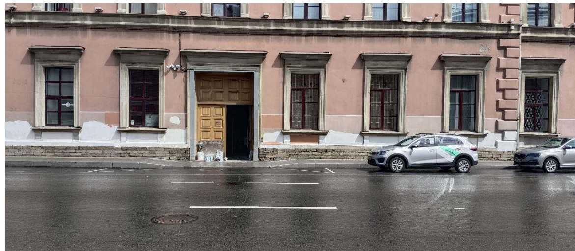
Ремонт фасадов ул. Труда и ул. Якубовича (PCO)
