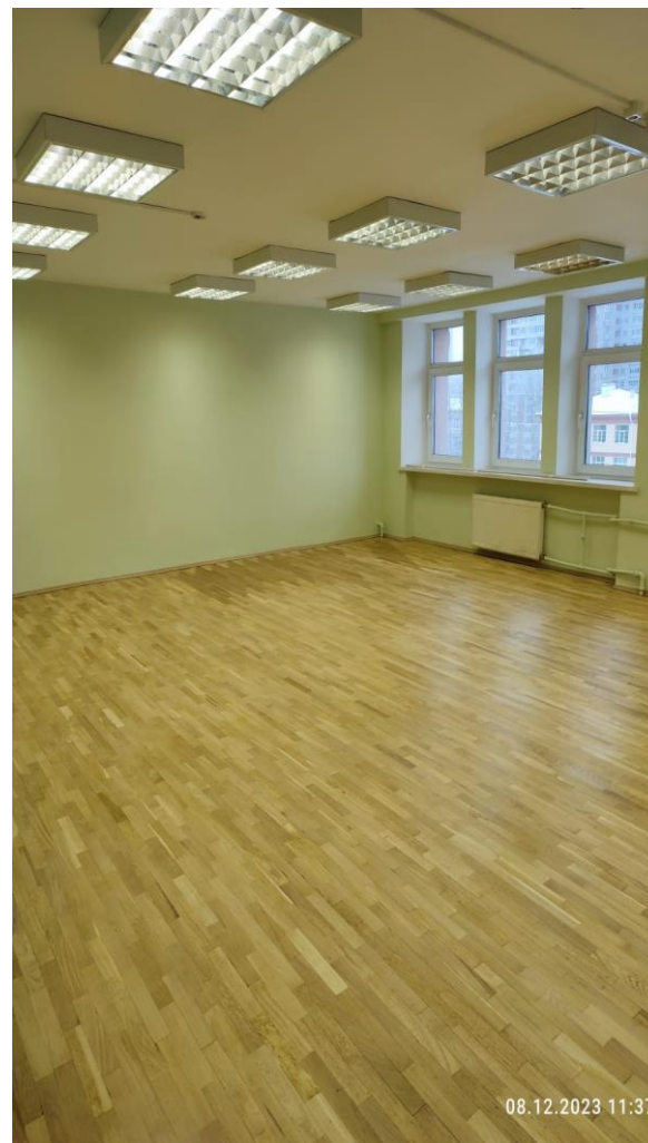
Косметический ремонт ауд. 612 и 617 (PCO)
