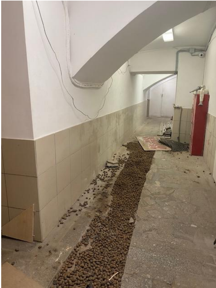
Аварийный ремонт ХВС и отопления 51-08В
