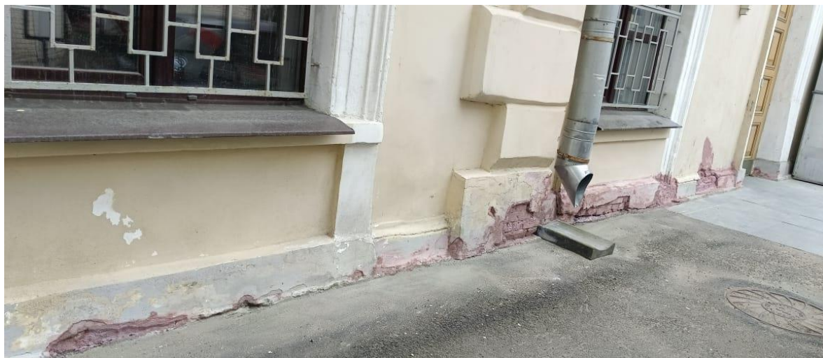
Ремонт фасадов Точки кипения (двор)
