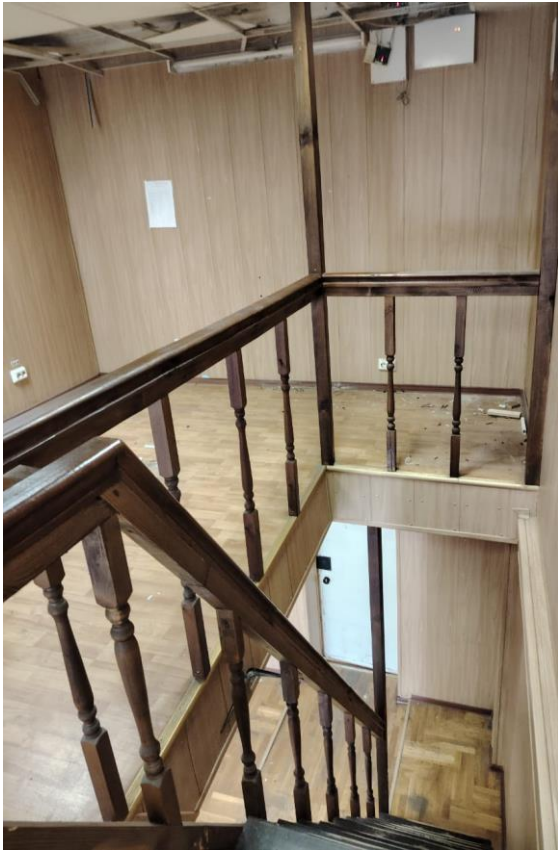
Ремонт помещения 52-27 (PCO)
