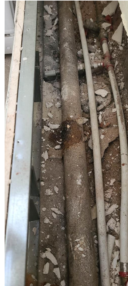
Аварийный ремонт ХВС и отопления ОКБ РЭС
