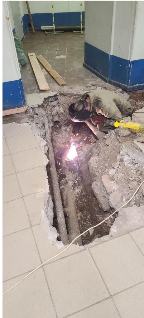
Аварийный ремонт трубопровода отопления лестница у РИЦ и Касс
